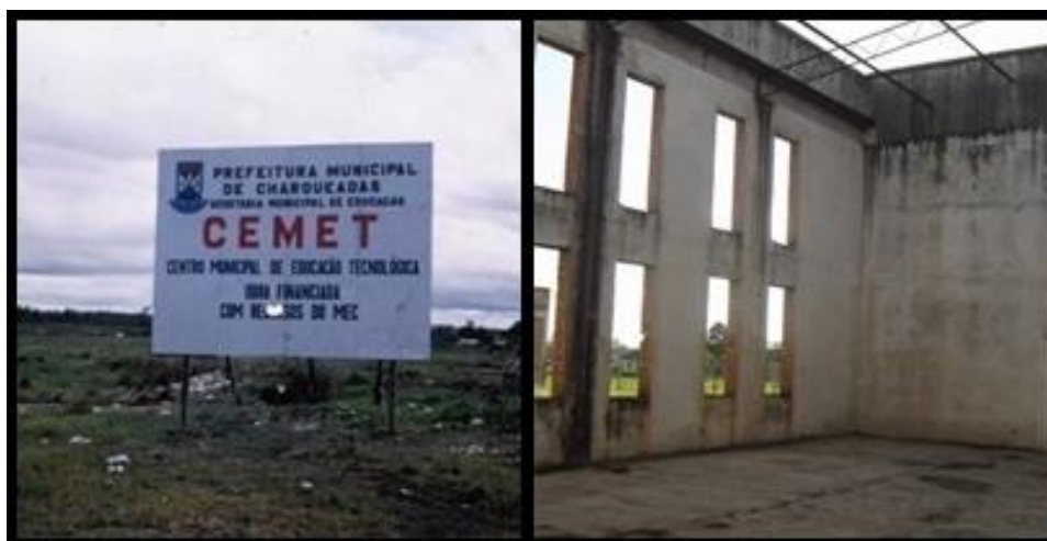
Figura 5 – Obras da Escola Técnica Municipal – Anos 90
